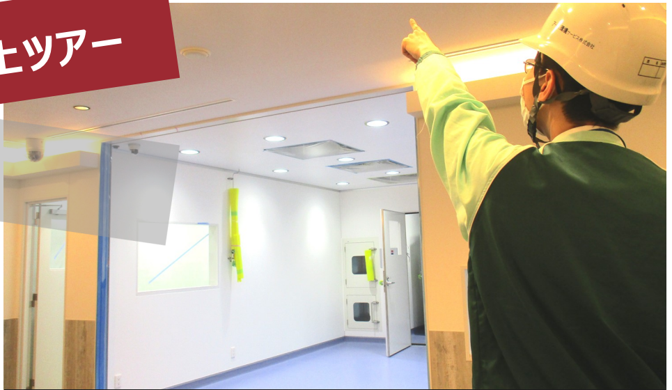
拡張工事もいよいよ最終段階。細胞培養室には大きな見学窓を設置する。
